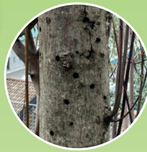
Fori di sfarfallamento
